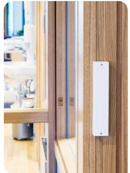
De hvite sensorene er så vidt synlige på dørkarmene.
